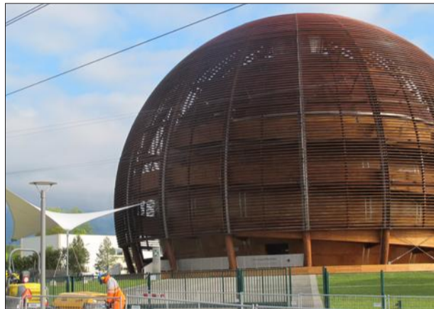
Sur l'Esplanade du Cern, place à la troisième phase des travaux, avec rétablissement de la circulation normale sur la route de Meyrin.
